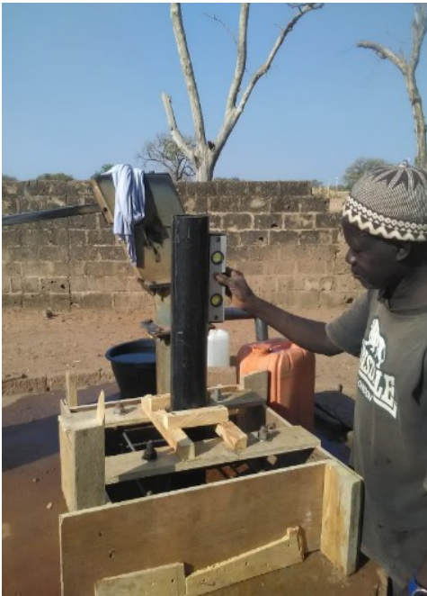
Installeren van de waterpomp
